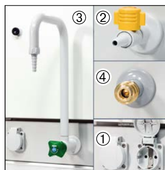
Przyłącza mediów do indywidualnego wyposażenia Państwa stanowiska pracy z materiałami niebezpiecznymi. Przyłącza te są montowane w kombinacji z cokołem mediów.
