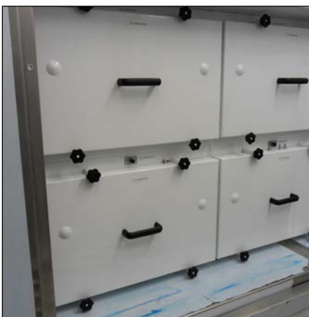
Obudowa filtra dla wymiany filtrów bez ryzyka skażenia
