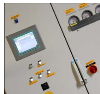
Główne pole obsługowe ze sterownikiem Siemens S7-300-SPS i monitorem HMI 10"
