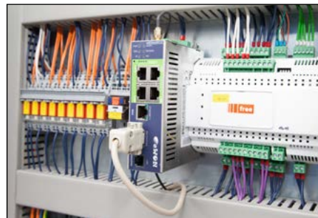
Podłączenie czujników monitorujących do systemu kierowania procesami u klienta
