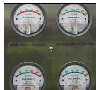
Ciśnieniomierze różnicowe Magnehelic z zaznaczonym zakresem bezpiecznej pracy
