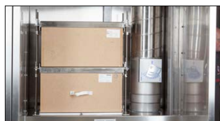
Filtry w ścianie tylnej swobodnego stanowiska roboczego
