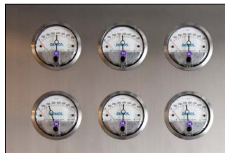
Analogowy lub cyfrowy monitoring różnicy ciśnień, prędkości i jakości powietrza
