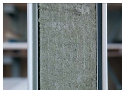
Izolacja ściany z wełny mineralnej (kl. mat. bud. A) łączenie z następnym panelem
