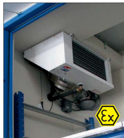
Agregat chłodniczy dzielony (widok od wewnątrz) w wersji przeciwwybuchowej.
