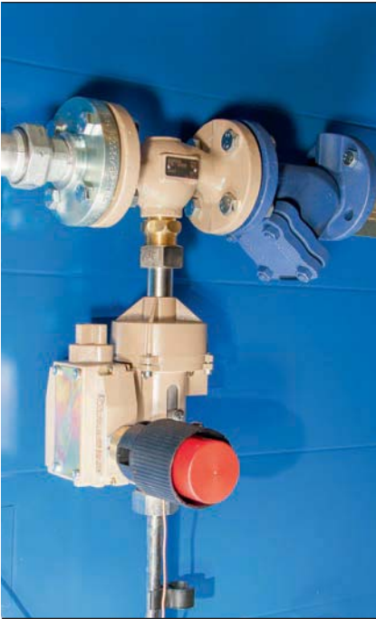
Ogrzewanie parowe z mechaniczną regulacją temperatury bez energii pomocniczej
