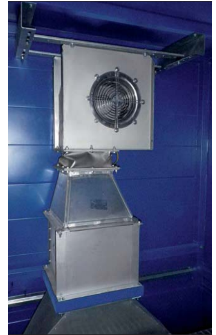
Elektryczne ogrzewanie powietrzne z cyfrową regulacją temperatury
