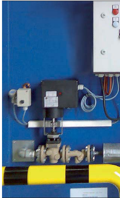
Ogrzewanie parowe z elektryczną regulacją temperatury
