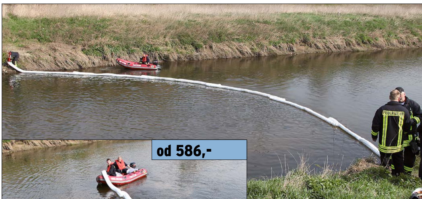
Zapory przeciwolejowe DENSORB (tu: segmenty 6 m) do otamowania wycieku i zbierania zanieczyszczeń olejowych z powierzchni wód
