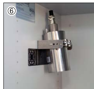
System tłumienia pożaru
